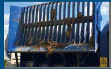
Separátor hrubého materiálu - na ochranu zásobníka v prípade veľkých nečistôt
